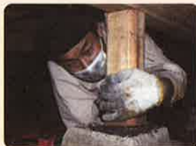
5 柱部分にも撒り込みます。
