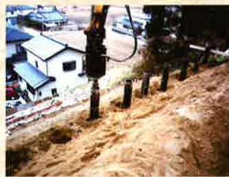
法面の安定化工事
