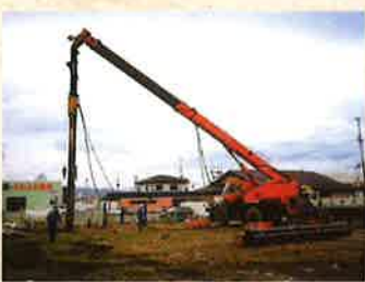
アポロンでの施工
