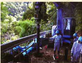
道路復旧工事
