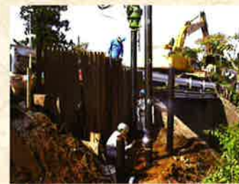
橋台基礎工事
