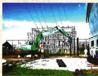
高圧線下での鉄塔基礎工事
