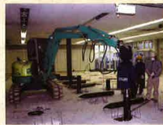
屋内でのスラブ補強工事
