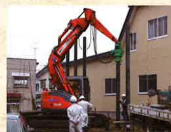
鉄骨3階建基礎杭工事
